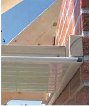
Folienbeschichtete Verkleidungsprofile müssen einen Dehnungsabstand von 15 mm zu den Außenkanten der Zusatzprofile haben.
